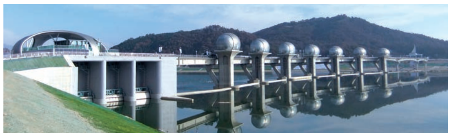
» Do vodní elektrárny Yipo v Jižní Koreji dodala společnost Mavel v roce 2011 tři Kaplanovy turbíny o celkovém instalovaném výkonu 3 330 kilowattů. Foto: Mavel
