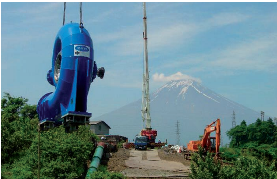
Společnost Mavel dodala v roce 2010 Francisovu turbínu o výkonu 140 kilowattů do japonské vodní elektrárny Fujiyoshida. (Více o společnosti Mavel čtěte na straně 17.) Foto: Mavel
